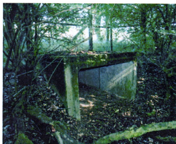
Рисунок А7 – Биопереходы трубного типа для отдельных видов мелких млекопитающих, пресмыкающихся и земноводных под полотном дороги
