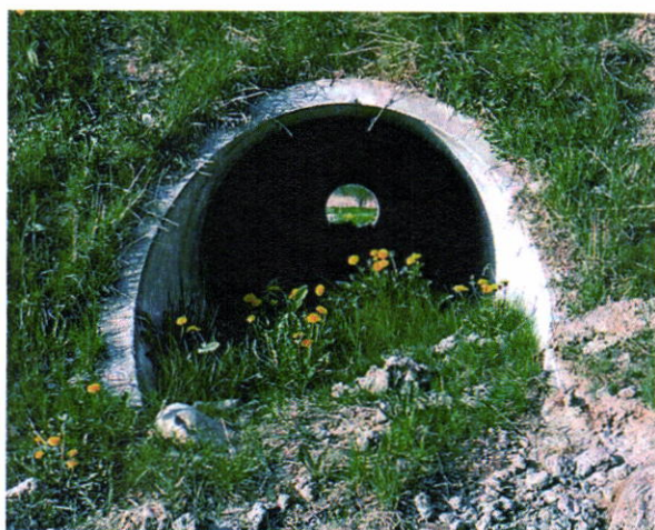
Рисунок А7 – Биопереходы трубного типа для отдельных видов мелких млекопитающих, пресмыкающихся и земноводных под полотном дороги
