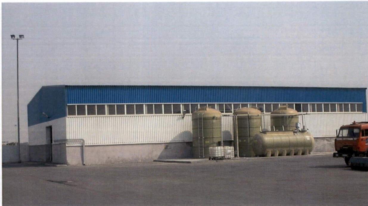
Рисунок Д.3 – Металлический склад химических ПГМ на бетонном фундаменте с рассолозаправочным пунктом
