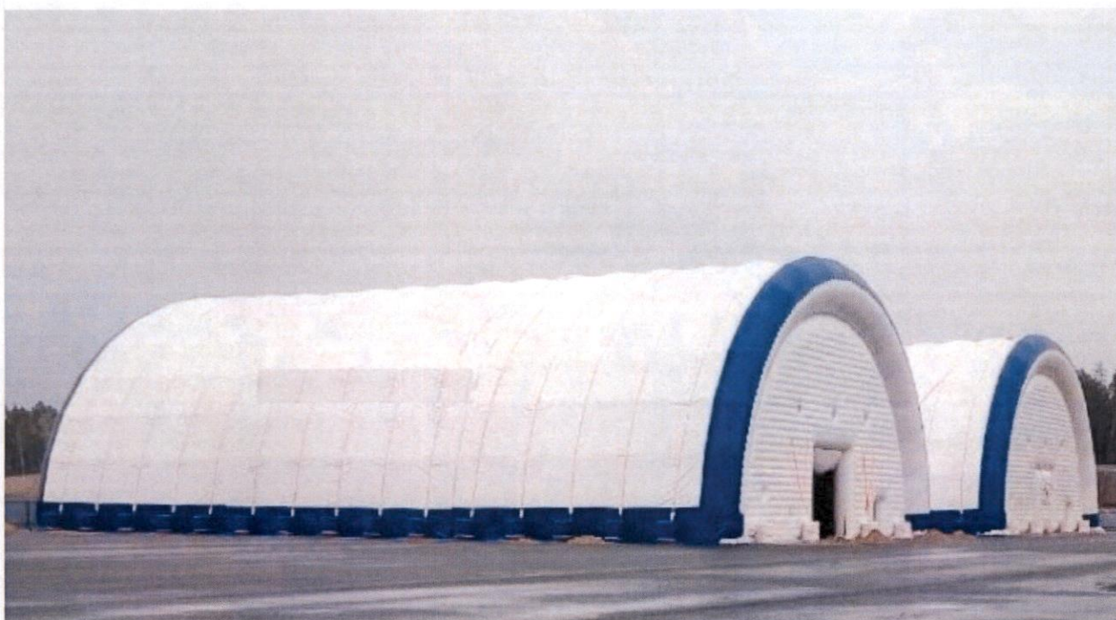
Рисунок Д.2 – Пневмоангар-склад химических ПГМ
