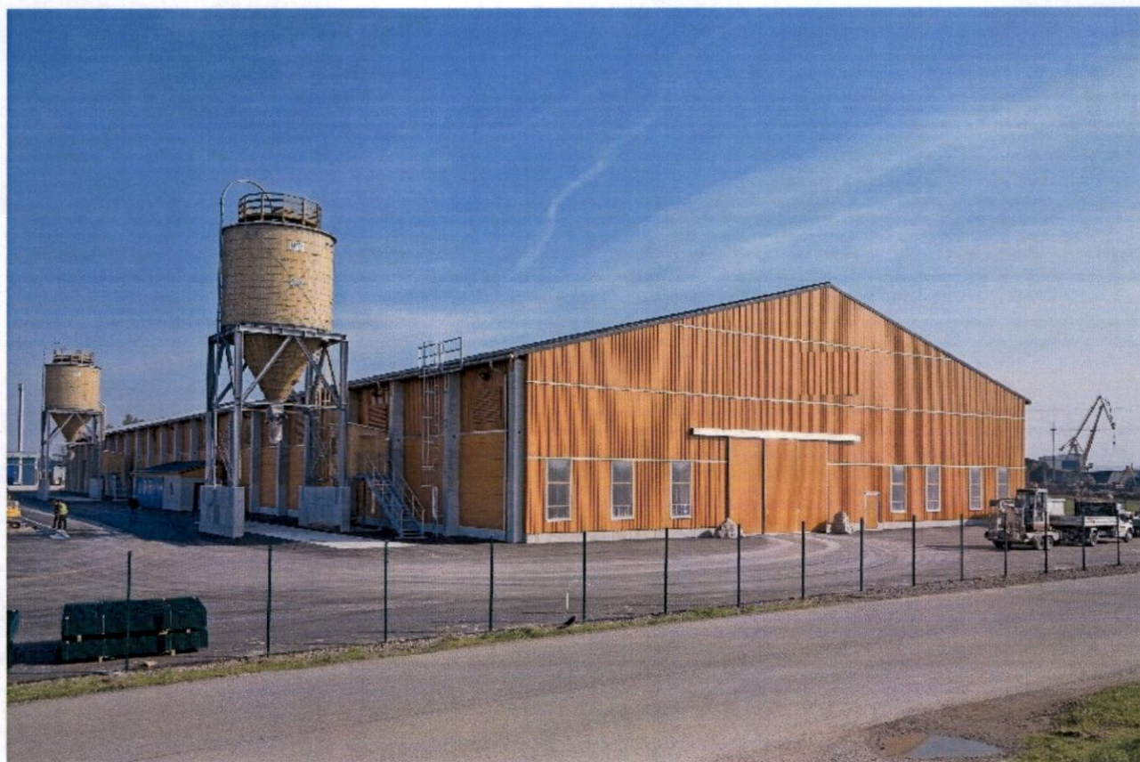
Рисунок Д.4 – Деревянный склад химических ПГМ на бетонном фундаменте с силосными установками для загрузки ПГМ В КДМ
