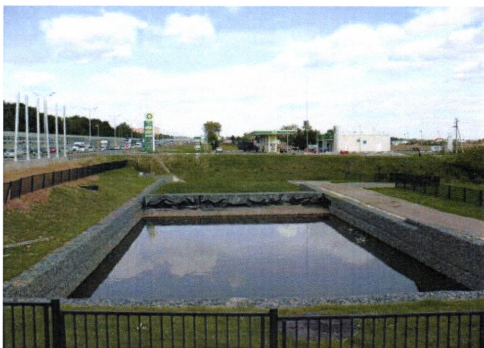
Рисунок А.2 – Пруд-отстойник каскадного типа с ГБП
