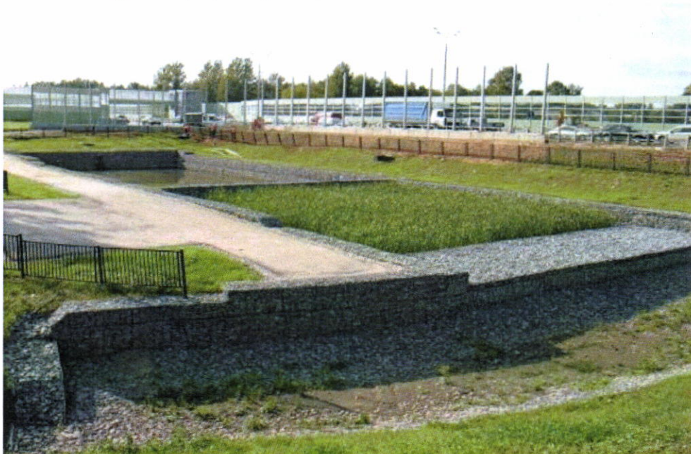
Рисунок А.1 – Пруд-отстойник каскадного типа с ГБП
