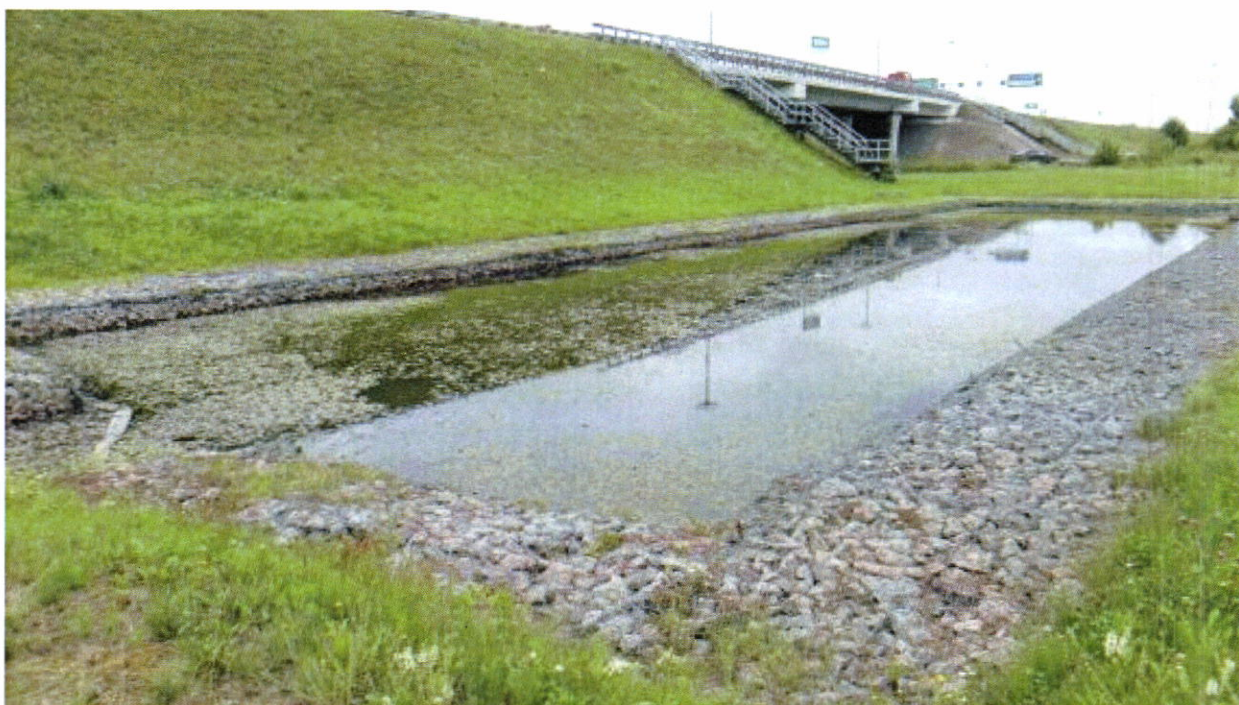
Рисунок А.5 – ГБП с устройством плавающих бонов из сорбирующего нефтепродукты материала
