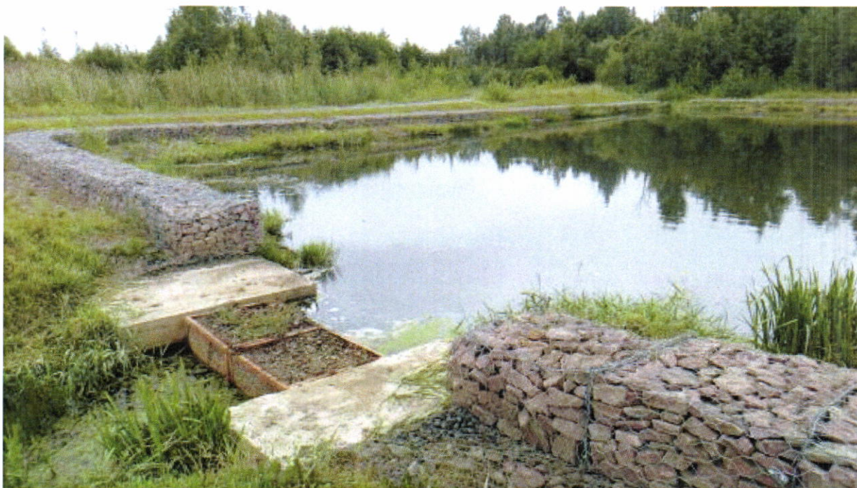
Рисунок А.6 – Фильтрующая кассета с загрузкой природным сорбентом
