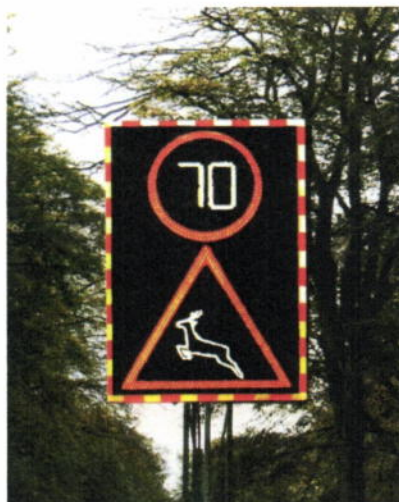
Рис. 2. Система предупреждения о выходе/приближении диких животных к автомобильной дороге
